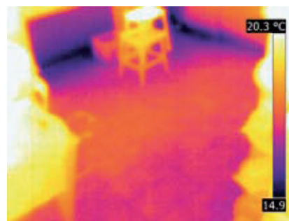
Infraroodfoto van een stenenvloer geïsoleerd met één thermokussen. Ondanks de hoge zijwaartse geleiding door plavuizen, onderlaag en de stenen vloer is een warmere strook zichtbaar.
